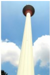
Menara Kuala Lumpur (Kuala Lumpur Tower)
